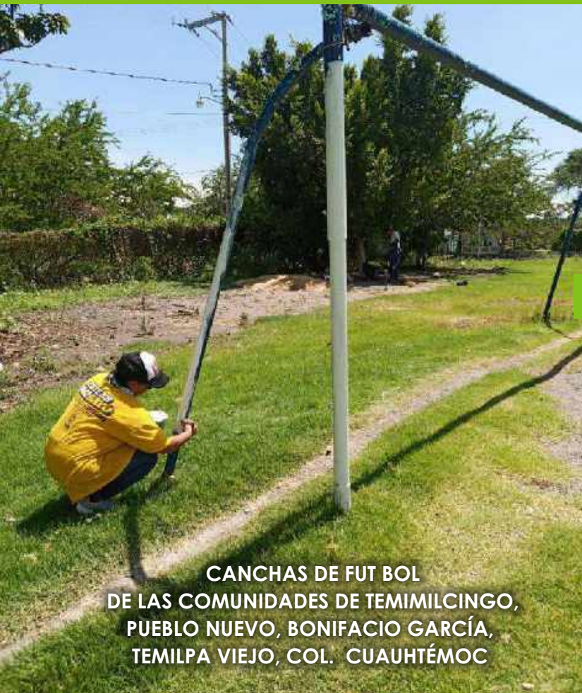
MANTENIMIENTO CON LA PODA DE PASTO Y PINTURA
