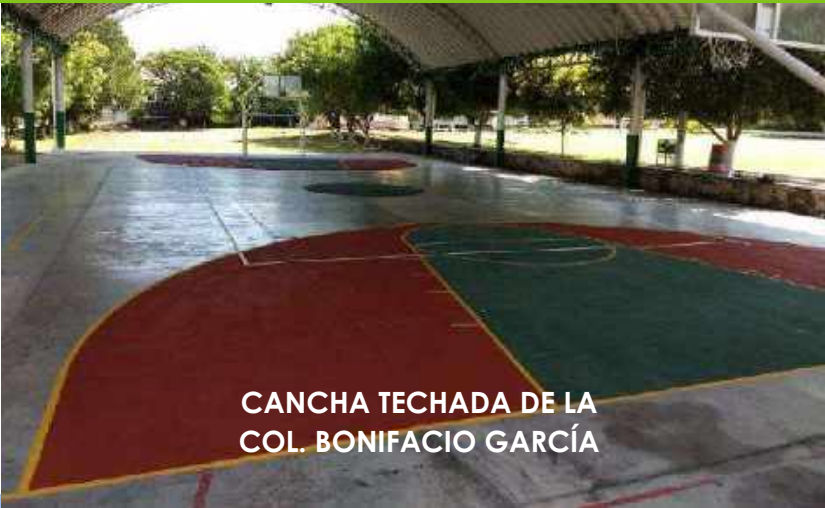
MANTENIMIENTO Y PINTURA
